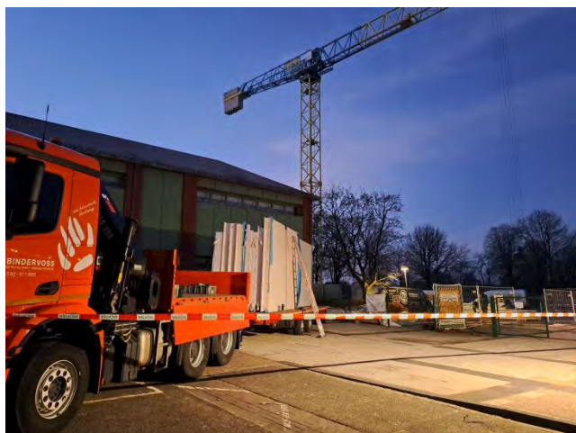
Schon vor dem Unterricht starten jeden Morgen die Bauarbeiten auf dem Schulgelände.
