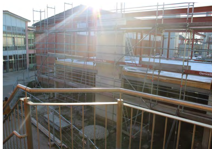
Von oben sieht man die ersten Fortschritte auf der OGS-Baustellen.
