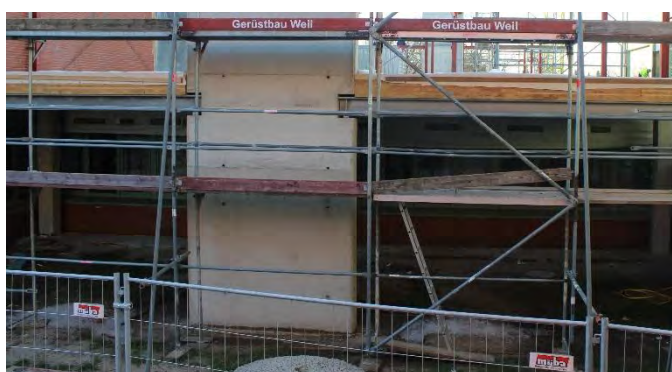
Unten sieht man nichts mehr aus dem Lehrerzimmerfenster. Ob die Lehrer jemals wieder Licht sehen werden?
